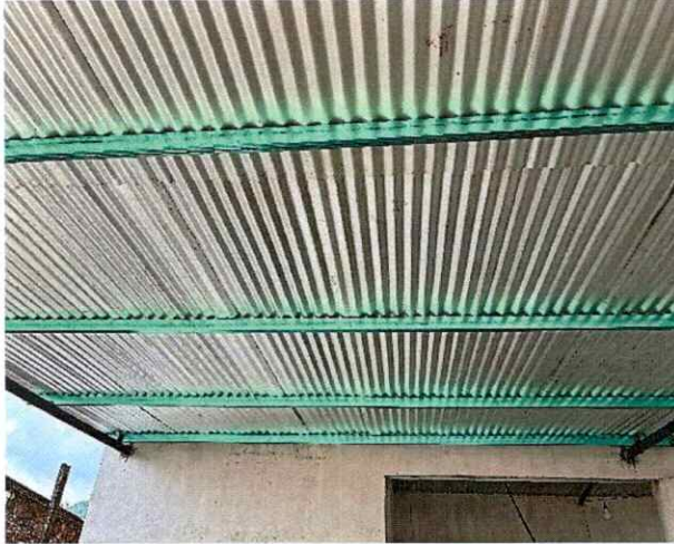
Rehabilitación de Techo Firme, Ranchería San Marcos
