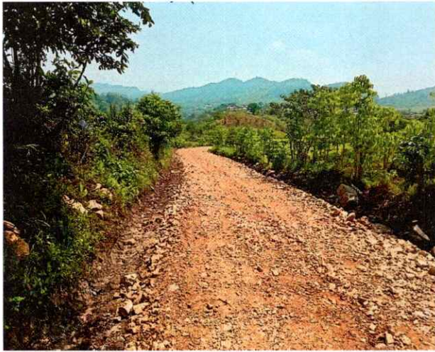
Apertura y Revestimiento de Camino, Ejido Rivera de la Selva
