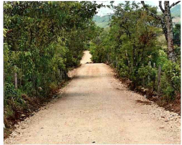
Revestimiento de Camino, Pinar del Río
