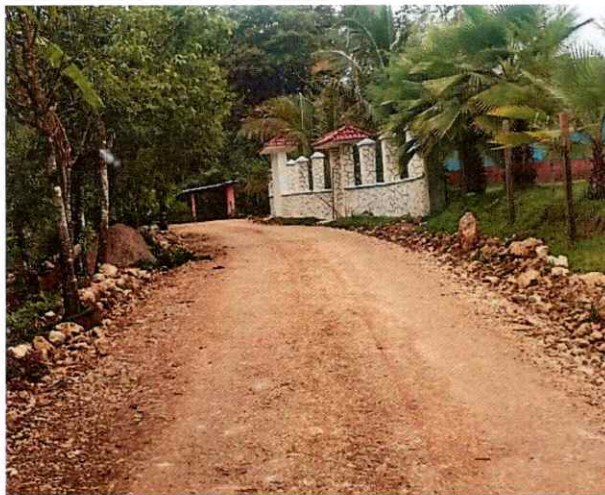
Revestimiento de Camino, Ejido Nuevo Ojo de Agua
