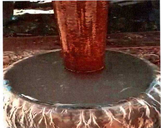
Perforación de Pozo Profundo, Ejido Venustiano Carranza
