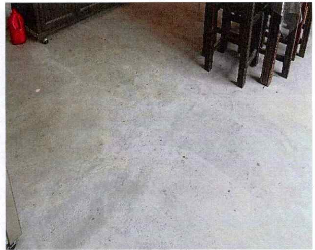
Construcción de Piso Firme, Ranchería La Florida
