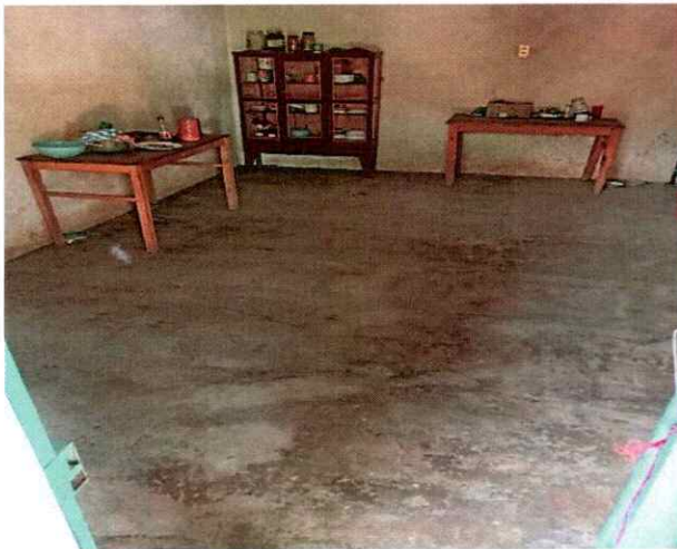
Construcción de Piso Firme, Anexo el Campamento
