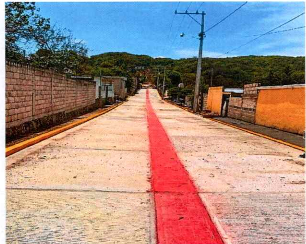
Pavimentación de calles y avenidas con concreto hidráulico, Barrio San Fermín, La Independencia
