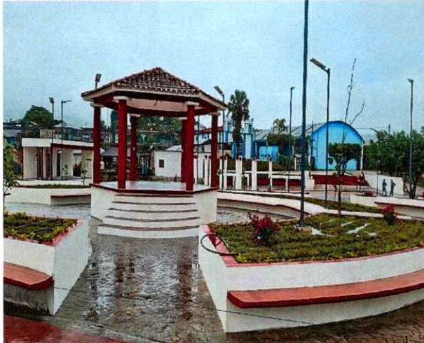
Construcción de Parque Público, Ejido Río Blanco
