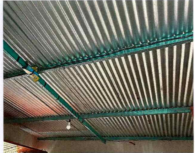
Rehabilitación de Techo Firme, Ranchería Chentón
