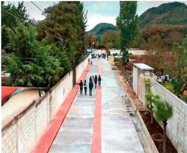
Pavimentación de calles con concreto hidráulico, Barrio Camino Real, La Independencia
