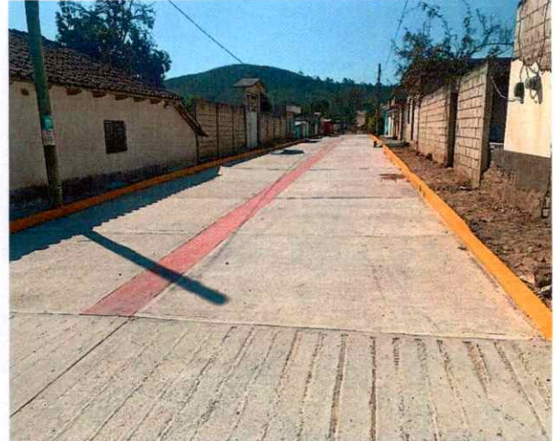
Pavimentación de calles con concreto hidráulico, Ejido El Triunfo
